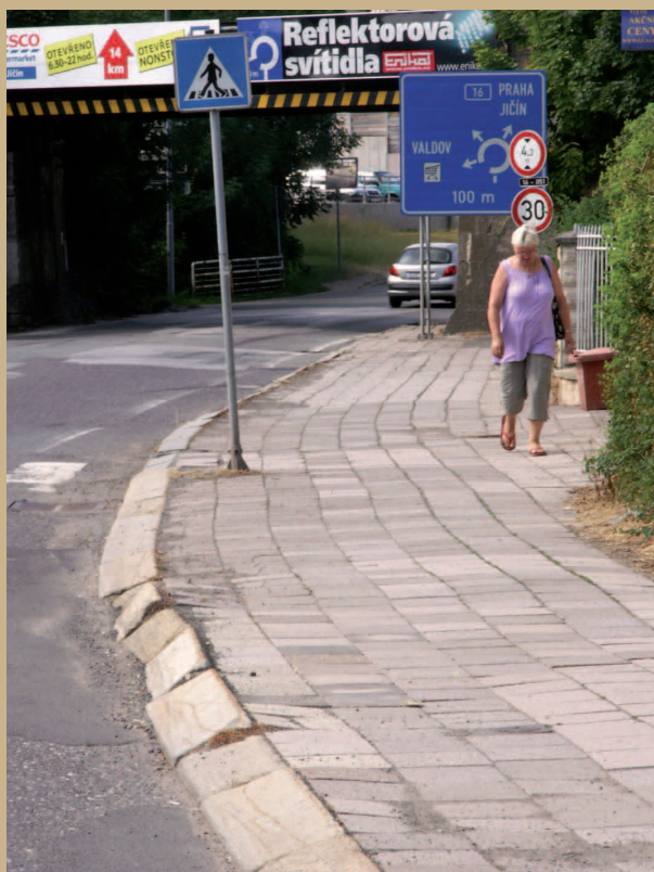
Od viaduktu, ulice Legjí – plánovaná akce č. 2. Srovnat obruby, nová dlažba, nové umístění autobusové zastávky. Zvažujeme pruh zeleně. Čekáme na rekonstrukci vozovky.
