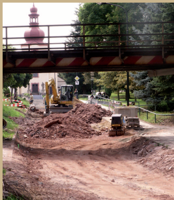
Rozkopaná „kaplička“ – až po Masarykovo náměstí je vše nové, pro chodce mnohem příhodnější, včetně přechodu na Dukelské nám (na ten nadávají jen řidiči – ale jezdí pomalu).
